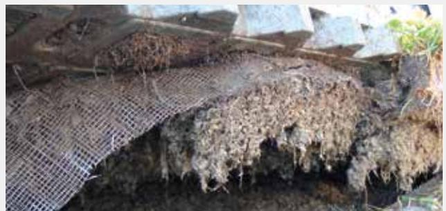
Intensives Wurzelwachstum - Baugrund/Vegetationstragschicht, Bettung und Verfüllung werden zum Wurzelraum (Prüfbericht LWG\* siehe Nachweise und Prüfzertifikate)
